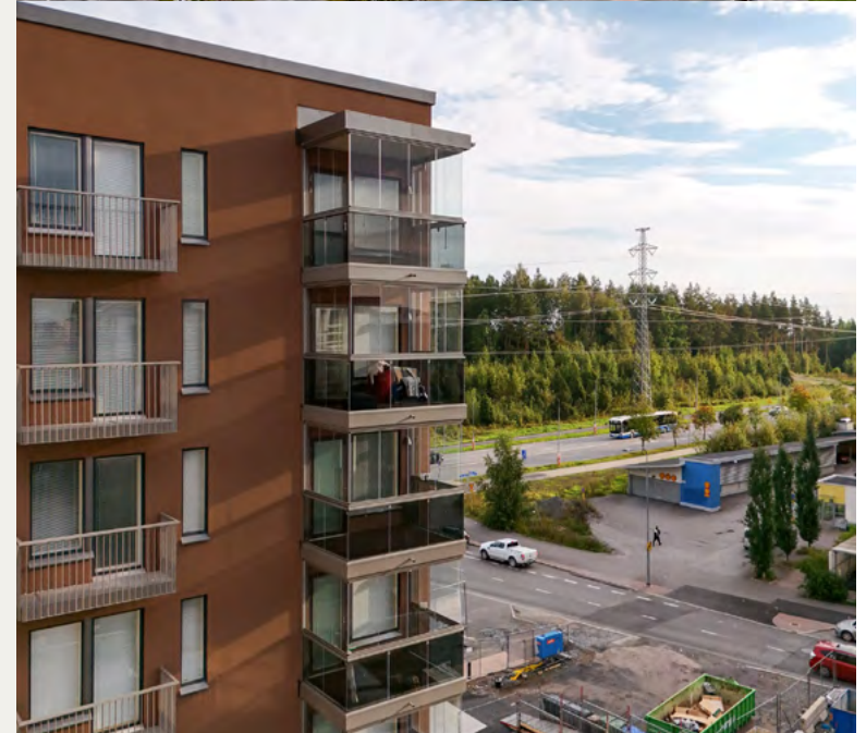
Seitsemäkerroksinen vuokratulo luovutettiin Pirkan Opiskelija-asunnot Oy:lle virheettömänä ja aikataulussaan elokuun 2025 lopussa.
