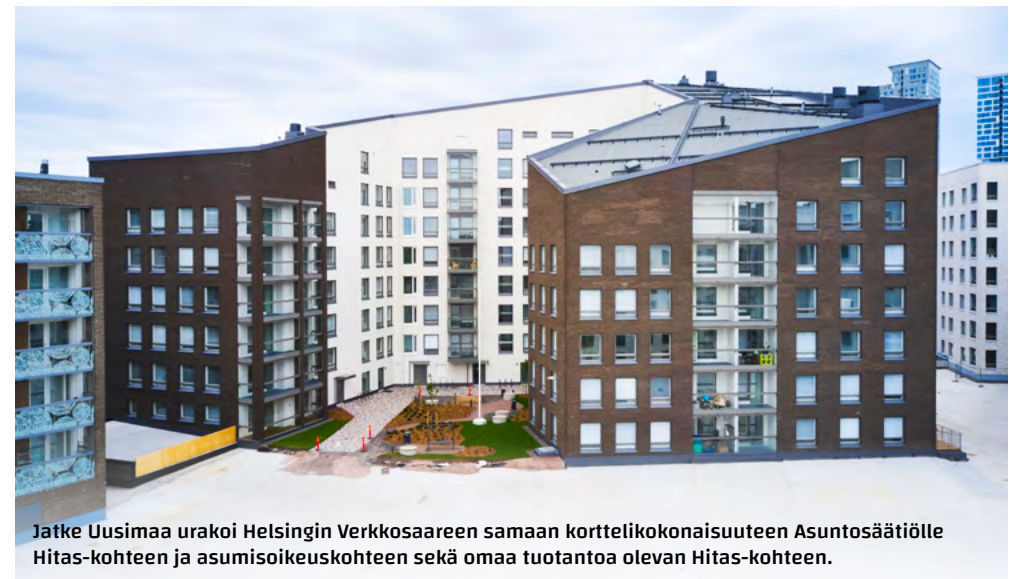
Jatke Toimitilojen Keilaniemen Portin hanke on menestynyt työturvallisuus- ja Vuoden työmaa -kilpailuissa.
