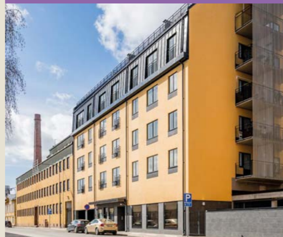
UUDISRAKENTAMINEN KÄYTTÄMÄTTÖMÄLLÄ TONTILLA
